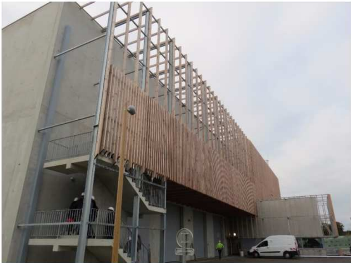
L'unité de combustion de plaquettes forestières, de la Sotraval, sur le site du Spernot.
