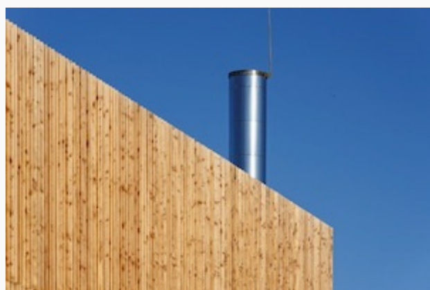
Cheminée de la chaufferie bois de Brest, photo Sotraval
