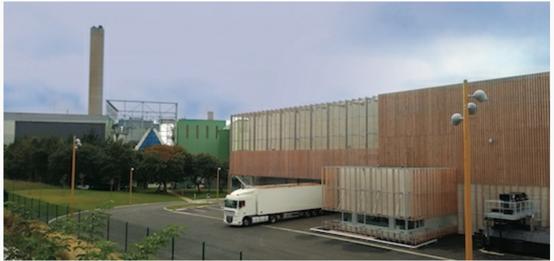
La chaufferie bois de Brest Spernot, et l'UVED en arrière-plan, photo Sotraval
