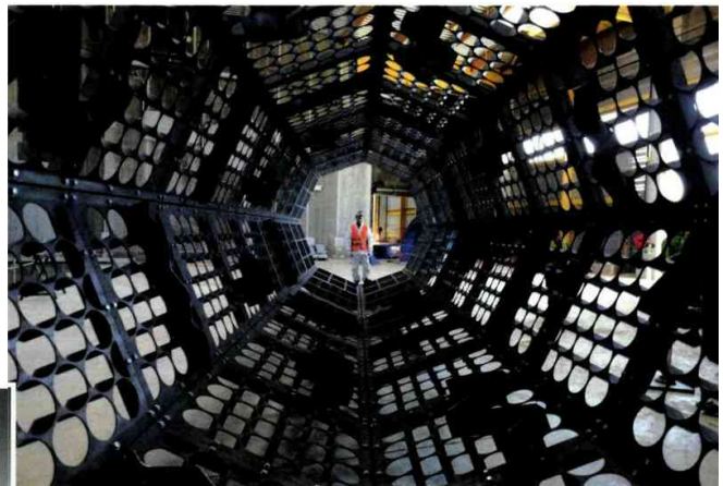
Vue intérieure d'un trommel, utilisé pour une première séparation mécanique des déchets entrants
