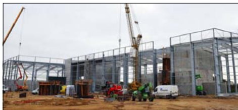
Le chantier a démarré en septembre dernier. Le bâtiment doit être hors d'eau fin décembre. La partie technique sera installée à partir de janvier, pour une mise en service prévue fin mars début avril 2013.
